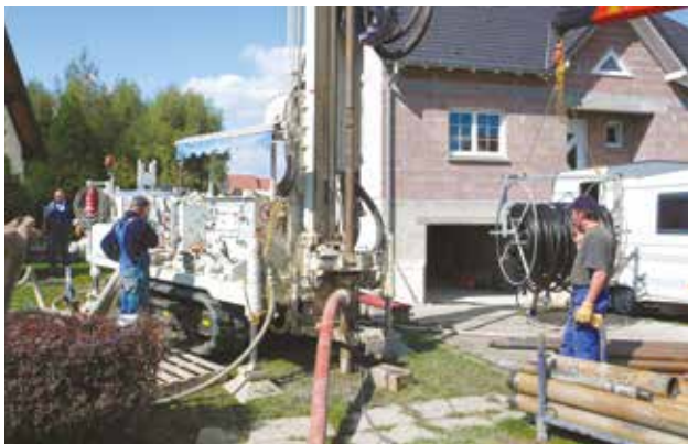
L'installation de sondes verticales nécessite de la place pour l'accès du camion de forage sur le site.
