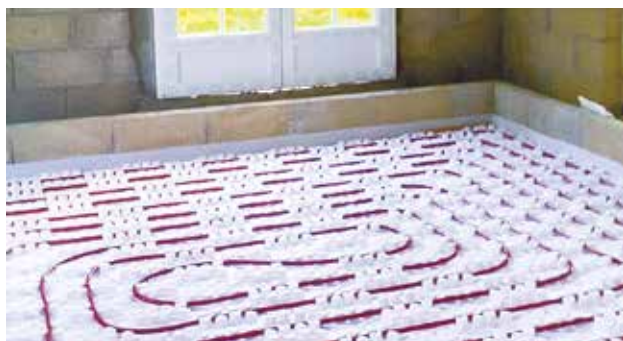
La pose d'un plancher chauffant est assez complexe en rénovation. Il est plus adapté à la construction neuve.
